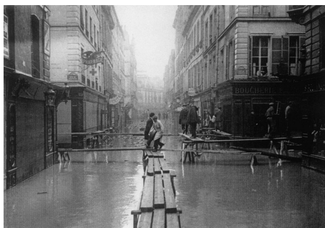
Figure 1.5 – Passerelles dans la rue du Bac (Paris) lors de l'inondation de janvier 1910 (Source : SIPA).
