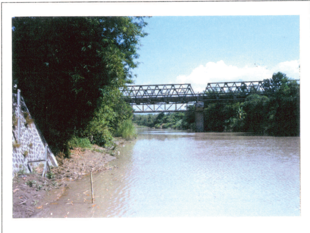
Figure 7.5. Station Jatiwangi (vue vers amont).
