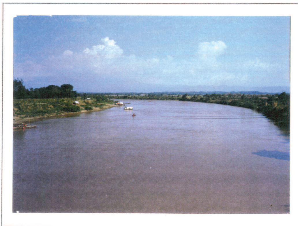
Figure 7.3b. Station Monjot (vue vers aval).
