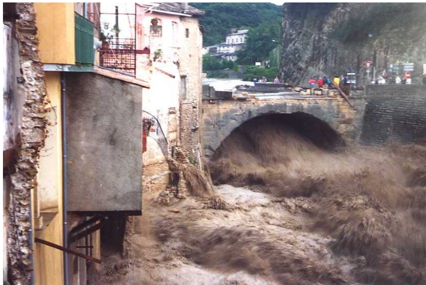
22 septembre 1992 : Crue de l'Ouvèze, Catastrophe de Vaison la Romaine, Photo MJ Tricart
