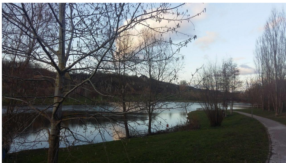
Le bassin d'orage de la Vallée du Bédât à Clermont-Ferrand, Photo I. Haddadi.
